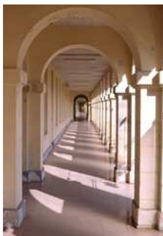
Bâtiment Pierre Lasjaunias
